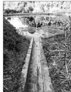
Canal al cantó més alt de la bassa que condueix l'aigua de pluja
