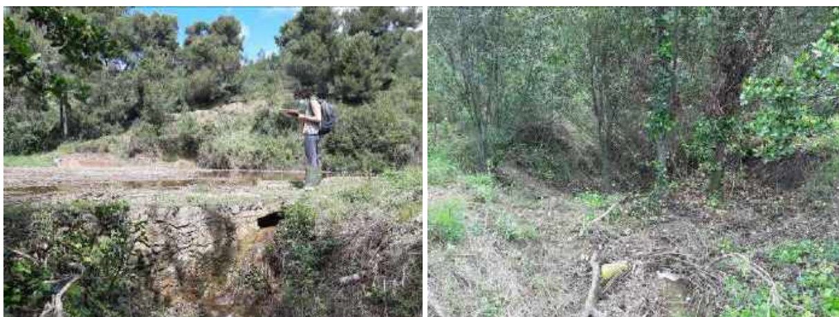
Imatges d'estat actual del punt de sobreexidor
