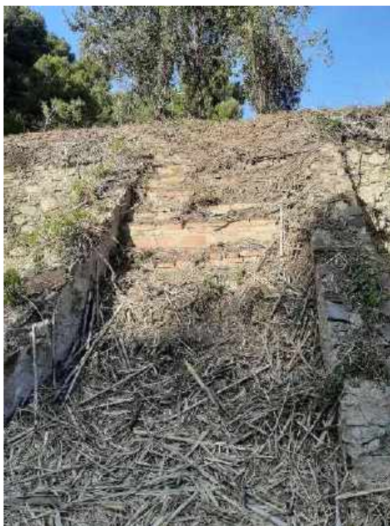
Escapes que salven el canal de drenatge de la sortida de la bassa
