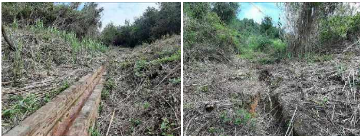
Canal d'accés a la bassa que recull l'aigua del torrent. Part central inexistent. La resta es conserva en bon estat.
