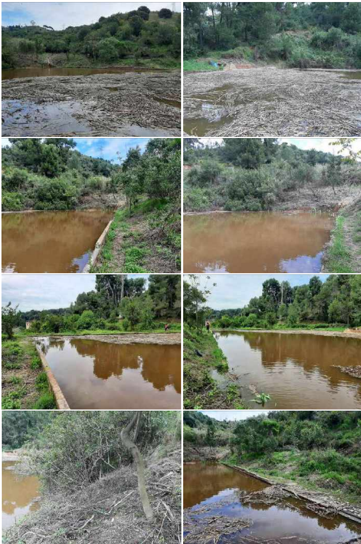
Vistes generals de la bassa desbrossada i després d'una pluja intensa
