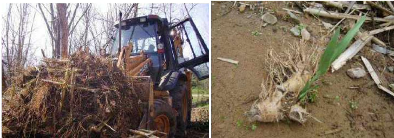
Retirada de canya amb retroexcavadora / Rizoma no enterrat que conserva les capacitats de rebrotar
