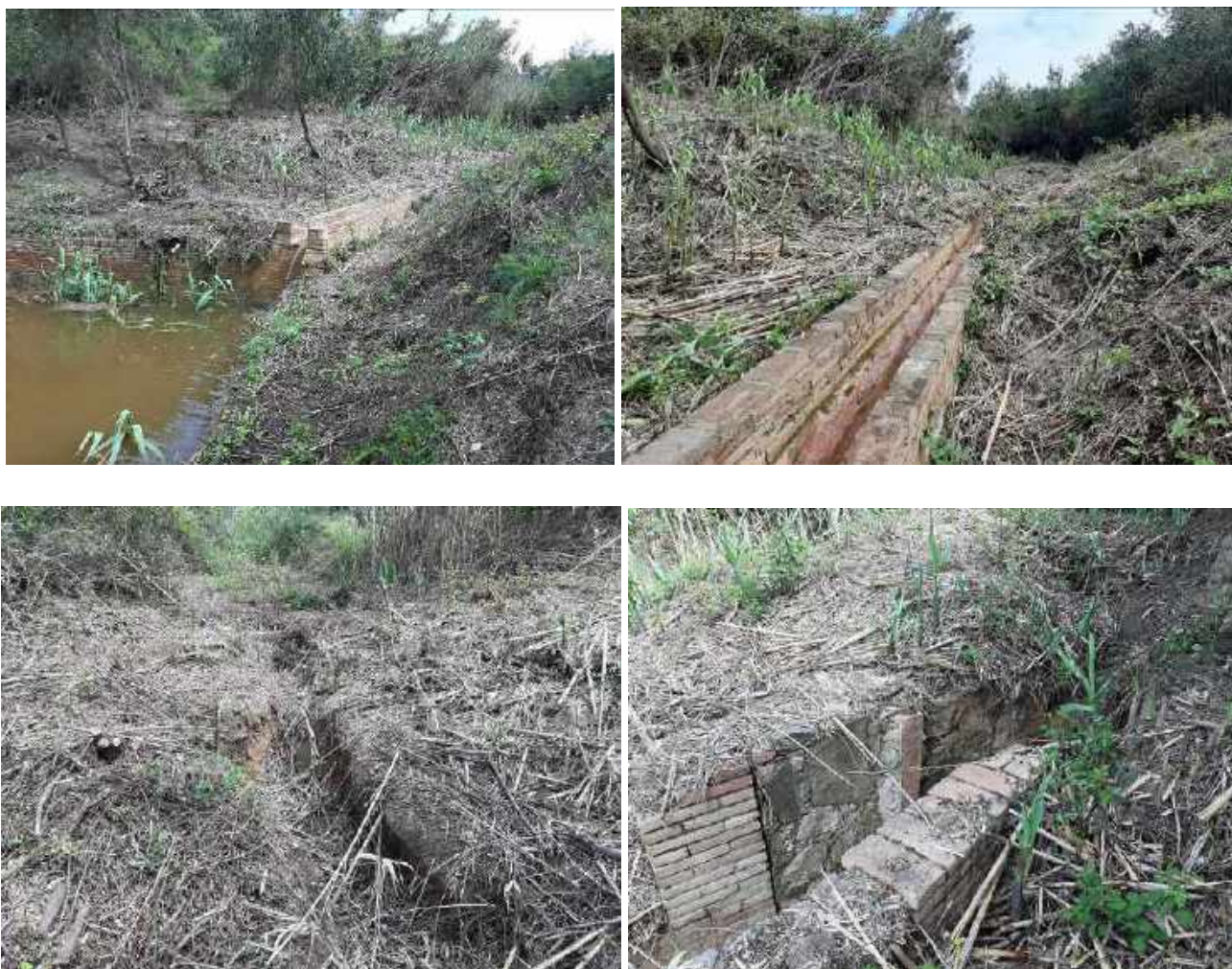
Imatges de l'estat actual del canal d'entrada
