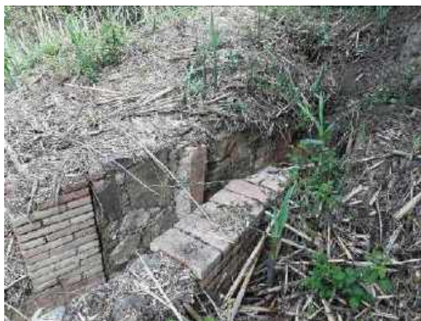
Inici del canal del torrent de la Ventosa
